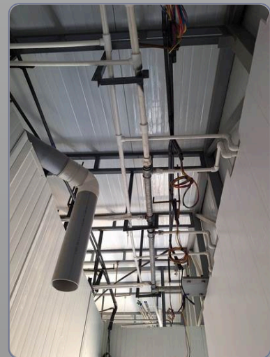
لوله کشی سرد و گرم و تاسیسات
