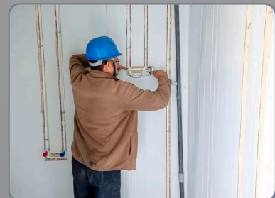
شکاف پانل برای اجرای توکار لوله
