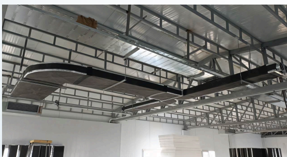
کانال ساخته شده با ورق گالوانیزه و عایق بندی
