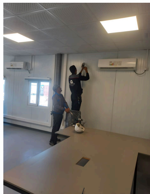
استفاده از اسپلیت دو حالت برای تامین گرمایش و سرمایش
