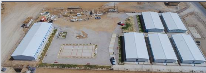
تجهیز کارگاه (پناه صنعت)
