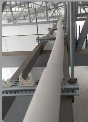
ساخت ساپورت لوله با پروفیل قوطی
