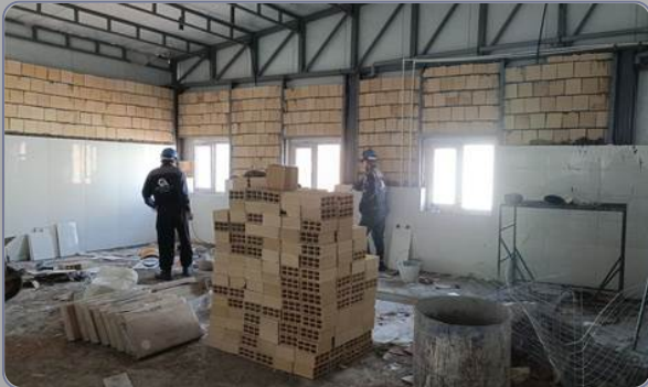
اجرای دیوار مطبخ با سفال جهت جلوگیری از آسیب حرارتی به پانل
