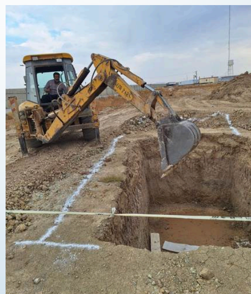
حفاری محل دفن سپتیک پلی اتیلنی
