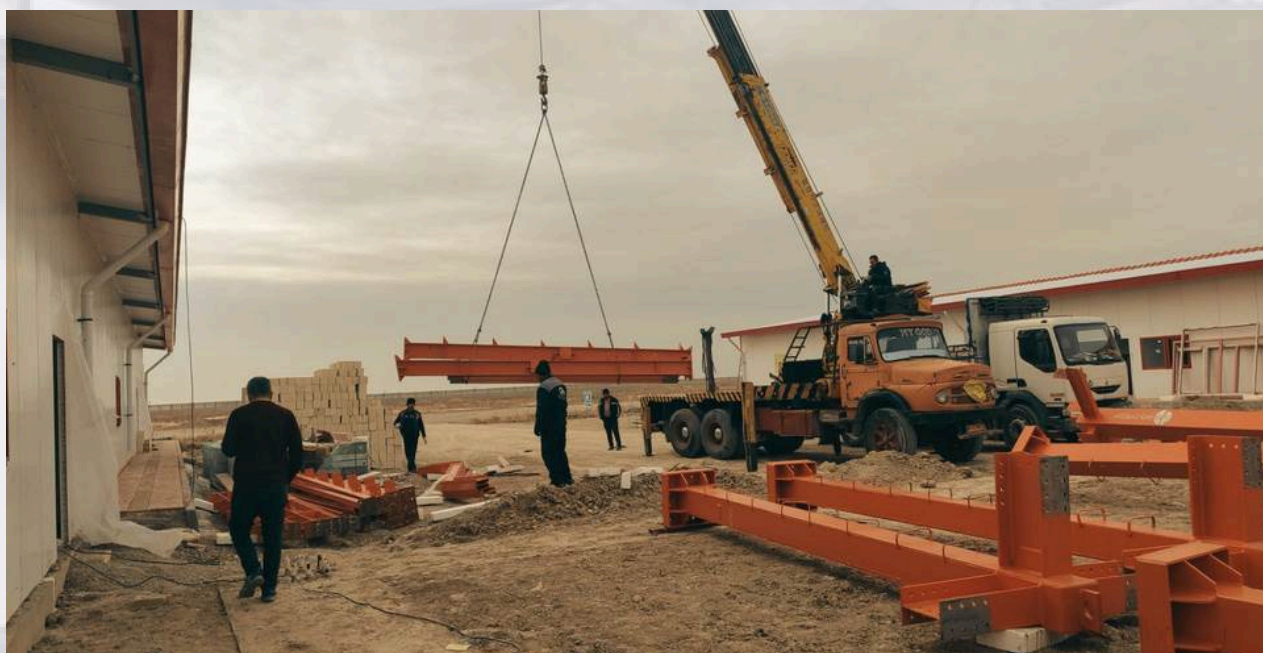
ساخت استراکچر رستوران پتروشیمی همدان به صورت قاب گیردار
