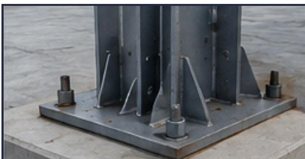
اتصال صلب با جوش و استیفر
